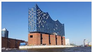
Die Elbphilharmonie ist ein bis Ende 2016 in Bau befindliches modernes Konzerthaus und ein neues Wahrzeichen Hamburgs (Foto: Mai 2016).
